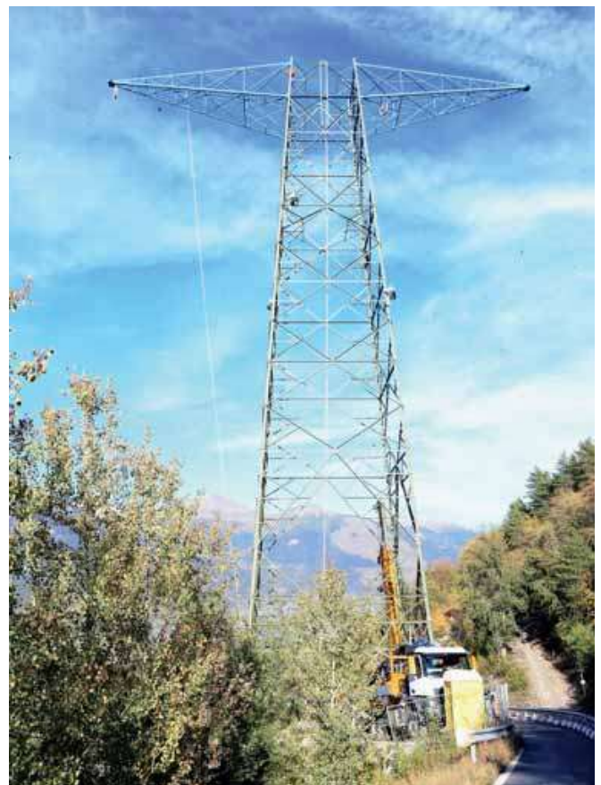
Un pylône en construction sur la route d'Anniviers. REMO
